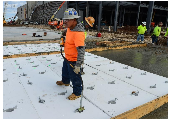
Foto de la izquierda: caminando sobre la espuma. Foto de la derecha: caminando sobre la espuma y aplicando vibración a los conectores IconX.
