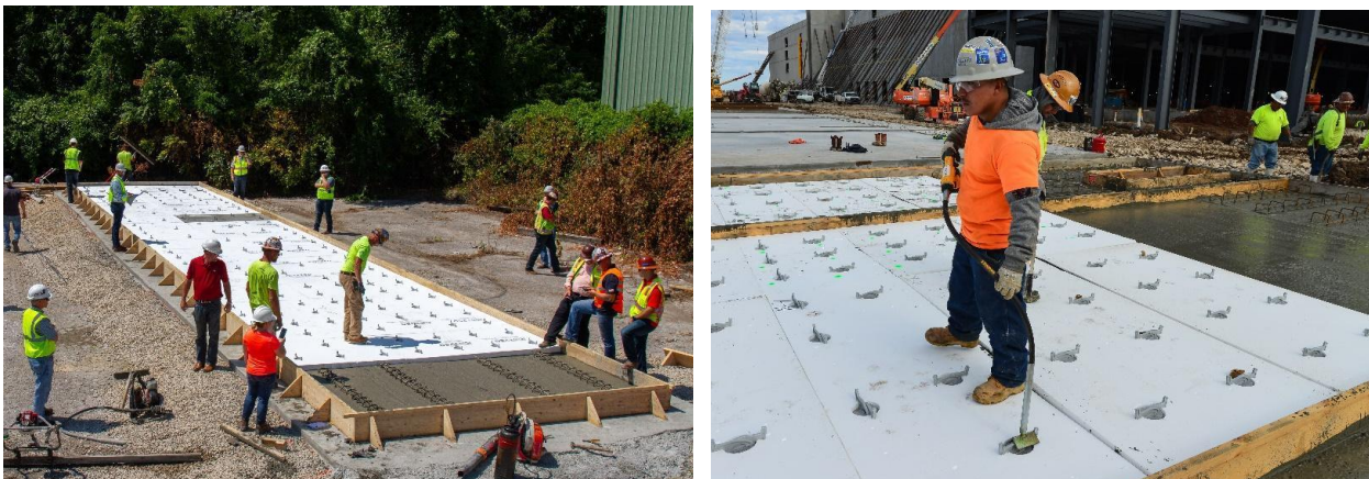
Foto de la izquierda: caminando sobre la espuma. Foto de la derecha: caminando sobre la espuma y aplicando vibración a los conectores IconX.
